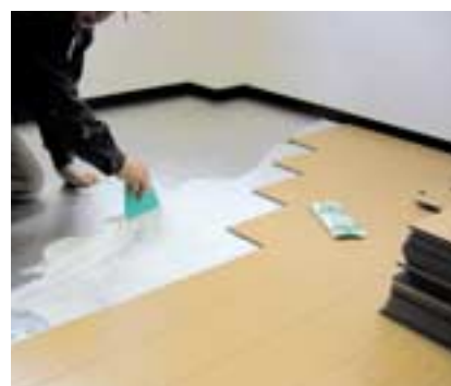
フローリングの施工
