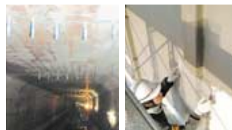
ひび割れ補修工事
