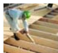
床下地の施工
