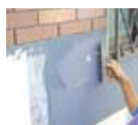
外壁タイルの施工
