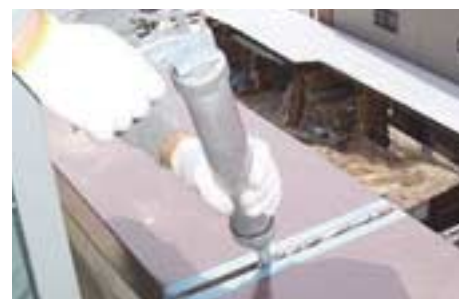
シーリング工事
