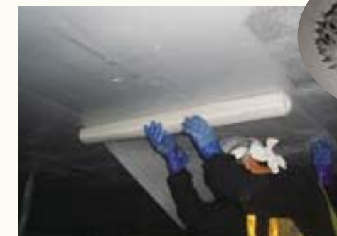
コンクリート天井の補修 コンクリート片のはく落を防止する「ボンドKEEPメンテ工法@VM-3」施工風景
